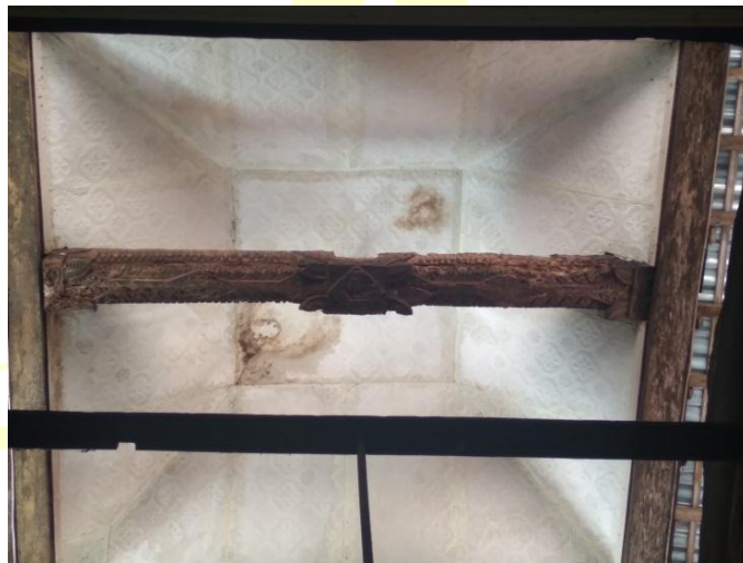
Gambar 3. Kuda-kuda atau sarah yang berada diatas /atap
