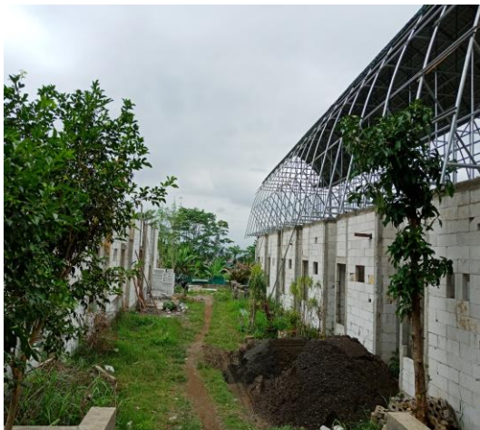
Foto 21: Hotel syariah (sedang dalam tahap pembangunan)
