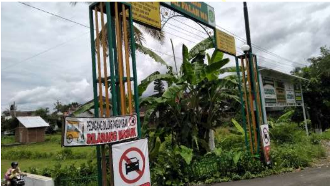
Kondisi gerbang pintu masuk menuju TPQ Al Falah
