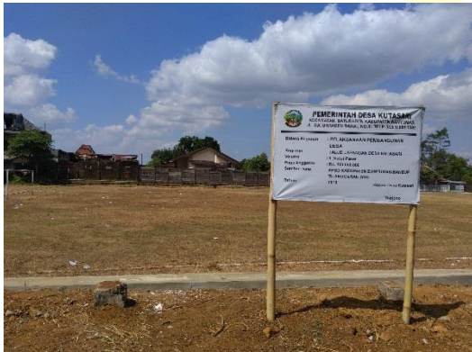
Papan informasi pembangunan talud lapangan Desa Kutasari.
