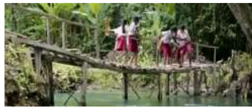
Gambar 1.4. dan 1.5. Ondeng menumpang pick up untuk pergi ke sekolah, Inal, Nia, Yanti dan Azkal harus melewati jembatan yang rapuh.
