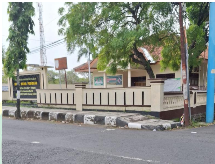
Gambar 5 Ujung Trotoar Tidak Ramah Disabilitas (Lokasi Depan Kantor Dinas Pendidikan Kec. Cilacap Tengah Jalan Kalimantan Tanggal: 9 Juni 2025 Sumber: Dokumentasi pribadi peneliti)
