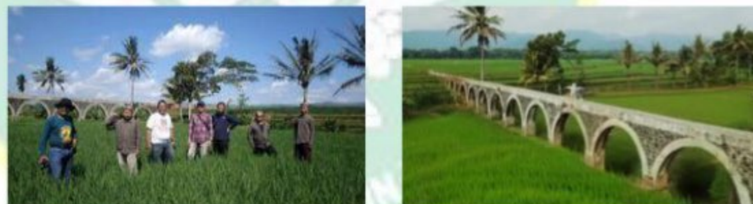
Gambar 4.5 Talang Gantung Desa Pagak Sumber : Dokumentasi Desa Pagak, 2024.
