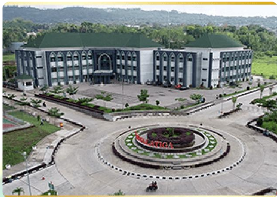
Gambar 5. Pembangunan gedung perkuliahan IAIN Salatiga Jawa Tengah, dibiayai dari Sukuk Negara T.A 2015-2016
