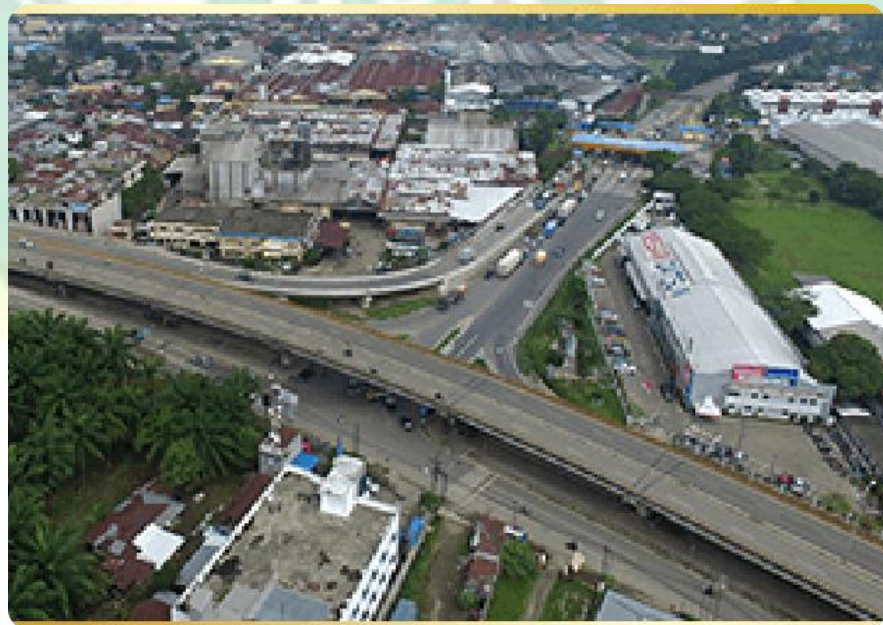
Gambar 2. Pembangunan Ramp on/off Flyover Amplas Medan, dibiayai dari Sukuk Negara T.A 2016
