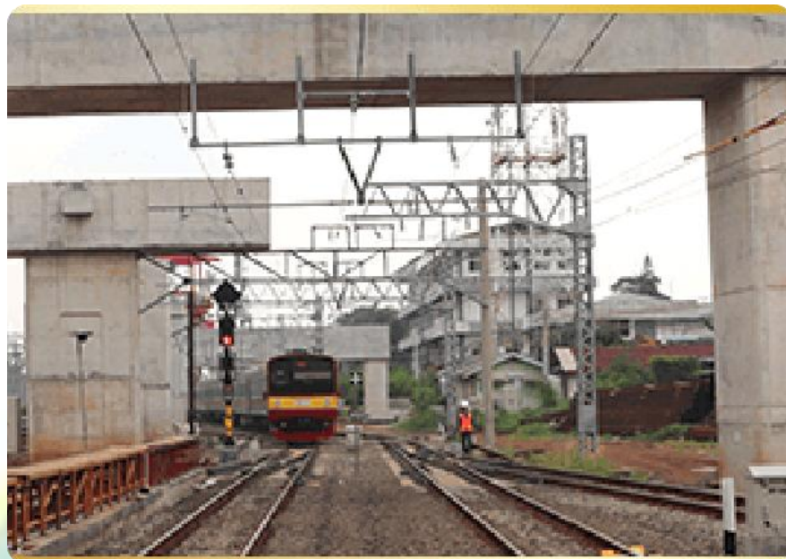
Gambar 11. Pembangunan Double-Doule Track KA Manggarai - Cikarang
