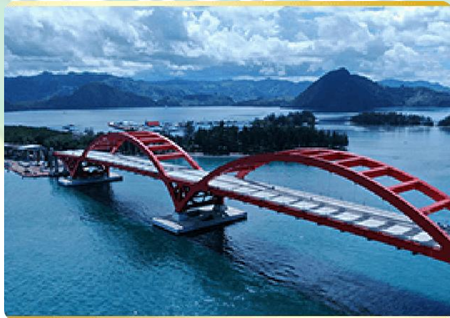
Gambar 8. Pembangunan Jembatan Youtefa (Holtekamp) - Papua
