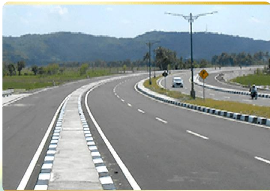
Gambar 3. Pembangunan Jalan Gerung Mataram NTB, dibiayai dari Sukuk Negara T.A 2015
