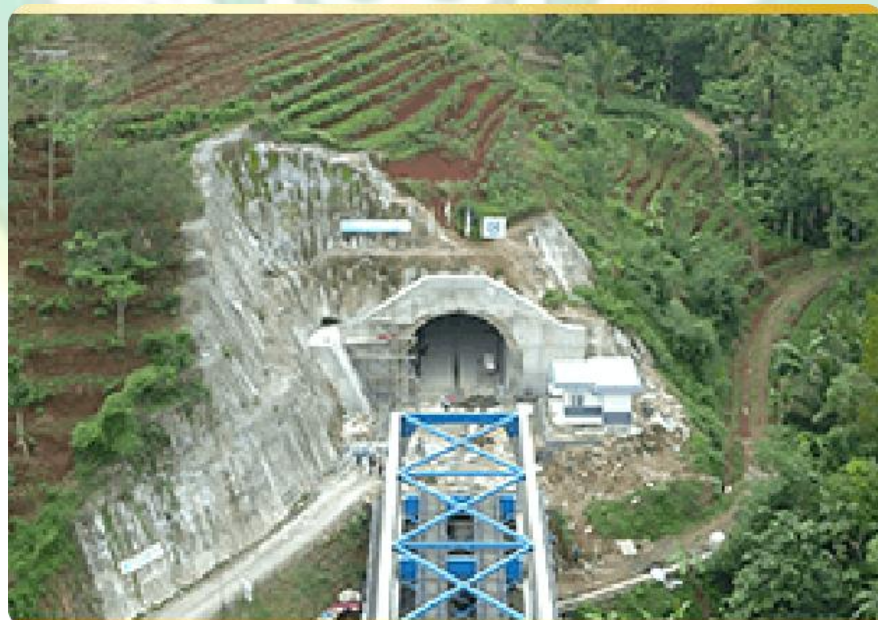
Gambar 12. Pembangunan Terowongan KA Notog - Banyumas
