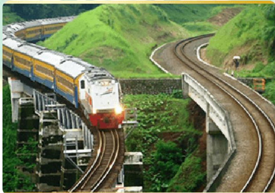
Gambar 6. Pembangunan Jalur Kereta Double Track Selatan Jawa Cirebon-Kroya-Solo-Madiun-Jombang, dibiayai dari Sukuk Negara T.A 2013-2019
