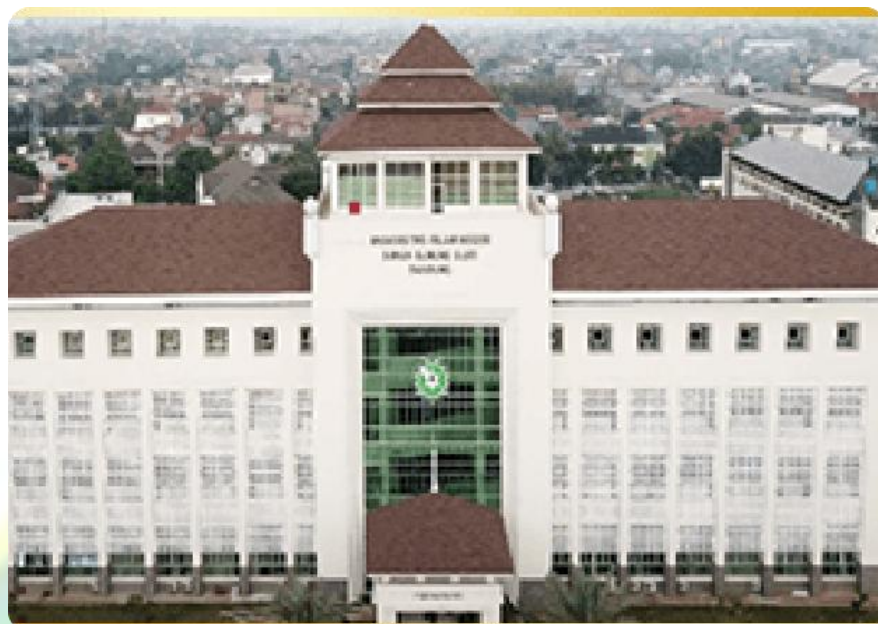
Gambar 9. Pembangunan Gedung Kuliah UIN Sunan Gunung Jati
