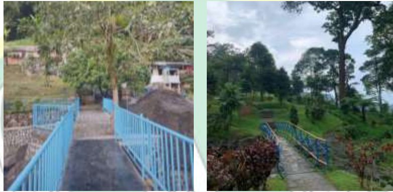
Gambar 4. 5 Jembatan Perlintasan dan Taman
