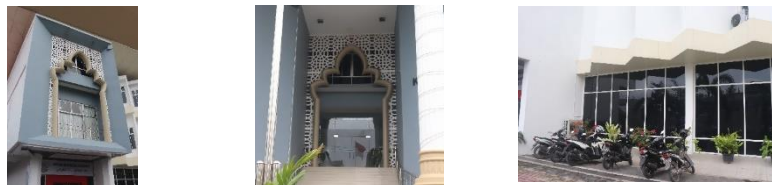
Gambar 8 Fasad Transparan gedung kantor Kejaksaan Negeri kota Lhokseumawe
