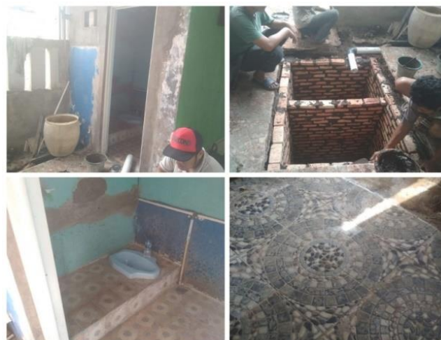
Gambar 3. Proses Pengerjaan Renovasi Toilet
