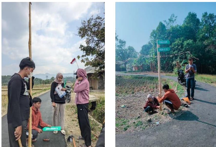
Gambar 16-17: Proses pembuatan papan nama jalan
