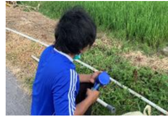
(b) Pemasangan flow meter pada pipa
