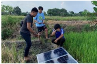
(a) Instalasi sel surya
