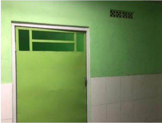
Gambar 6. Ventilasi di toilet SLB Negeri Karanganyar (sumber: Dokumen Penulis, 2023)
