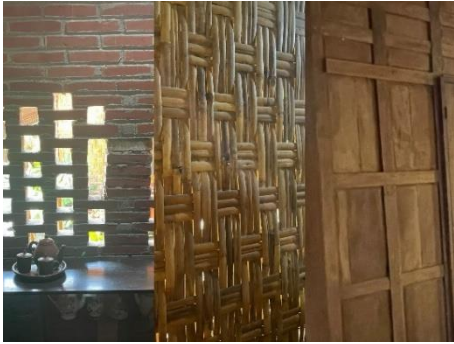
Gambar 22. Material Dinding Pada Homestay (Sumber: Dokumentasi Penulis, 2023)
