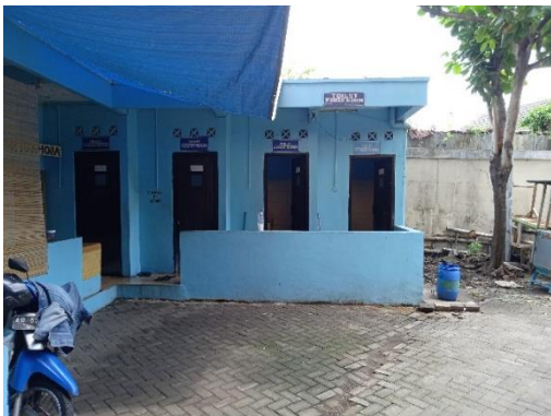
Gambar 6. Kondisi Luar Toilet (Sumber : Dokumen Penulis, 2023)
