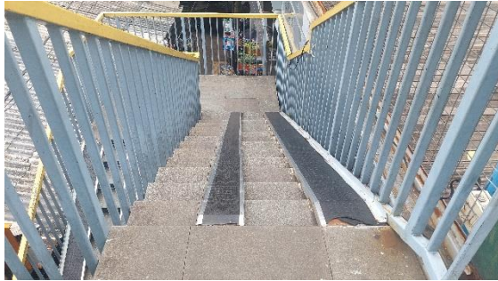
Gambar 10. Ramp pada tangga akses (Sumber: Dokumen Penulis, 2023)
