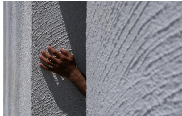
Gambar 9. Tekstur plester pada dinding (Sumber: Abdel, 2022)
