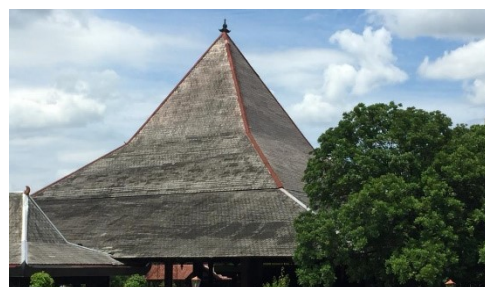
Gambar 3. Atap Bangunan Pendopo (Sumber: Survei, 2021)
