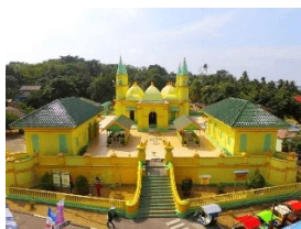
Gambar 11. Keadaan Masjid Tampak Atas (Sumber: Fajriah, 2020)
