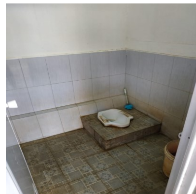
Gambar 21. Toilet dan WC (Sumber: Dokumen Peneliti, 2021)
