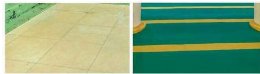
Gambar 12. Lantai dan Karpet Masjid (Sumber: Dokumen Pribadi, 2021)
