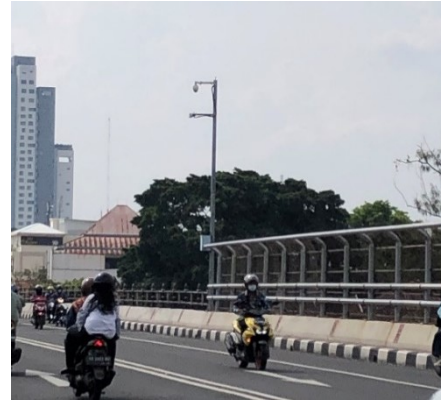
Gambar 9. CCTV Flyover Purwosari (Sumber: Dokumen Pribadi, 2021)
