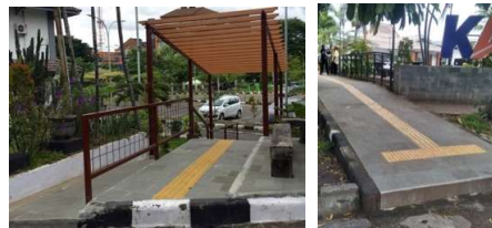
Gambar 5 Pedestrian (Sumber : Dokumentasi Pribadi, 2020)
