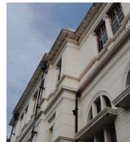
Gambar 6. Dinding Bank Indonesia Lama Surakarta (sumber: Dokumen Pribadi, 2020)
