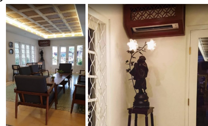
Gambar 7. Gambar AC Split Bangunan C (sumber: maps.google.co.id)
