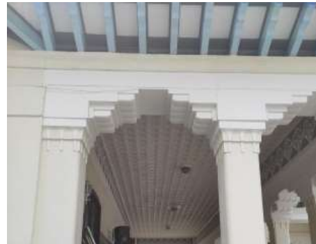
Gambar 17. Ornamen berulang garis dan lengkung pada kolom Teras Depan
