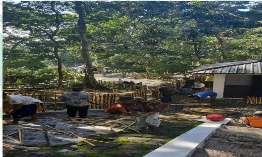
Gambar 2.7. Prosesi Pemasangan dan Pembuatan Pagar
