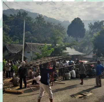
Persiapan Pemasangan Pagar
