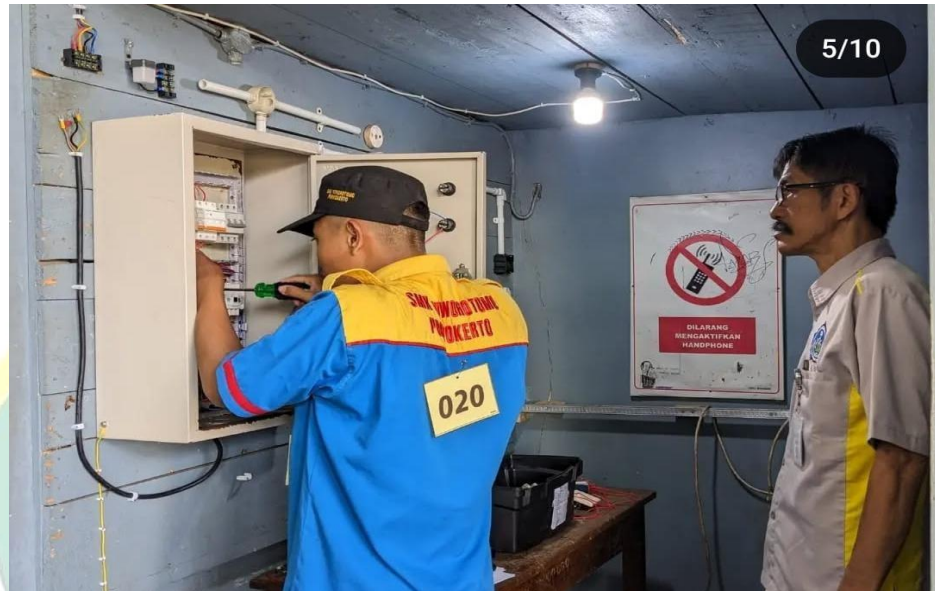
Gambar 9. Praktik Jurusan Teknik Instalasi Tenaga Listrik (TITL)
