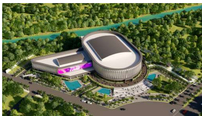
Gambar 9. Plaza Pada Bagian Depan Bangunan. Sumber: Data Pribadi, 2024.
