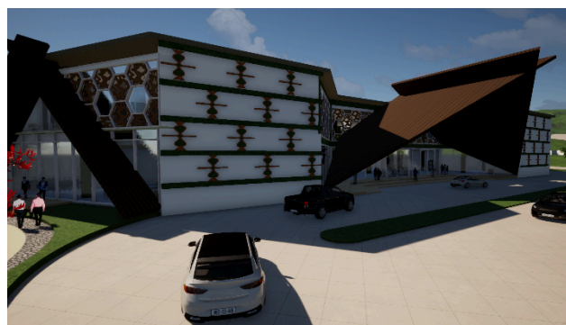
Gambar 9 Sisi Bangunan Sumber :Penulis, 30 Juni 2024
