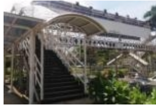
Gambar 6. Jembatan Penyeberangan Orang (JPO) (Sumber: Tribunnews.com)
