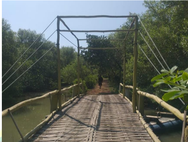
Gambar. 4.16 Jalan Tanpa penerangan
