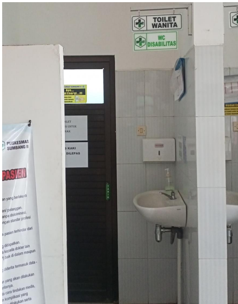
Gambar 7. Toilet khusus disabilitas di Puskesmas II Sumbang
