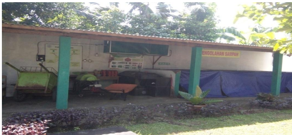
Gambar 18. Fasilitas pengolahan sampah sebagai fasilitas sanitasi sekolah.
