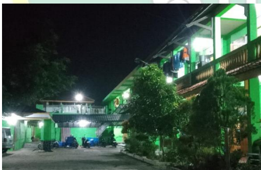
Gambar 17. Keadaan Gedung Asrama
