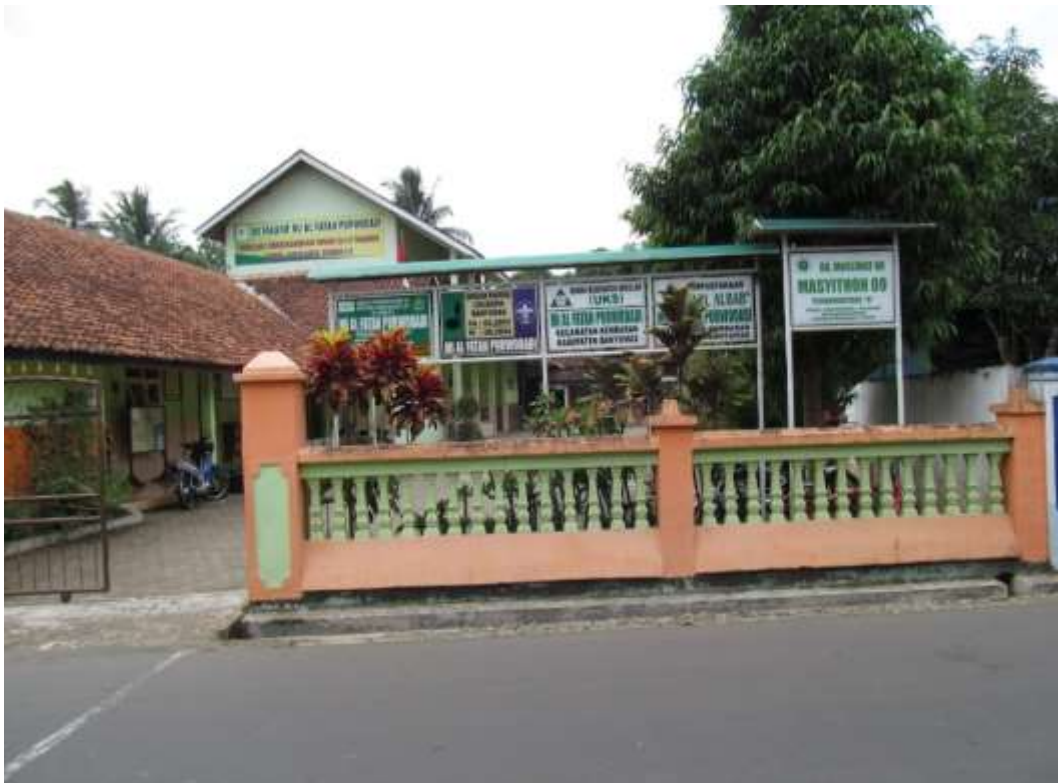
Gambar 5. Gedung MI Al Fatah Purwodadi
