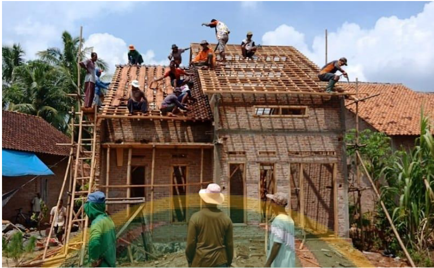
Pelaksanaan pemasangan Atap
