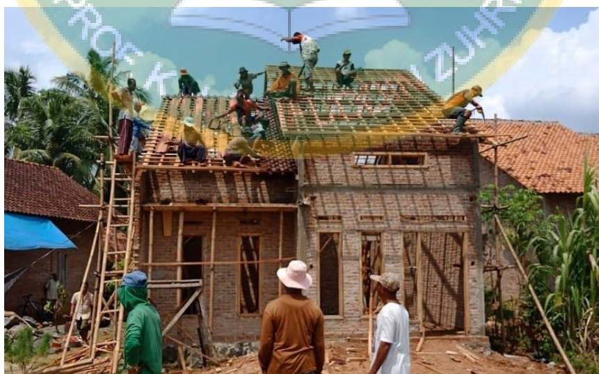
Gambar 2.2 Pelaksanaan Pemasangan Atap (Sumber: Dokumen Pribadi)
