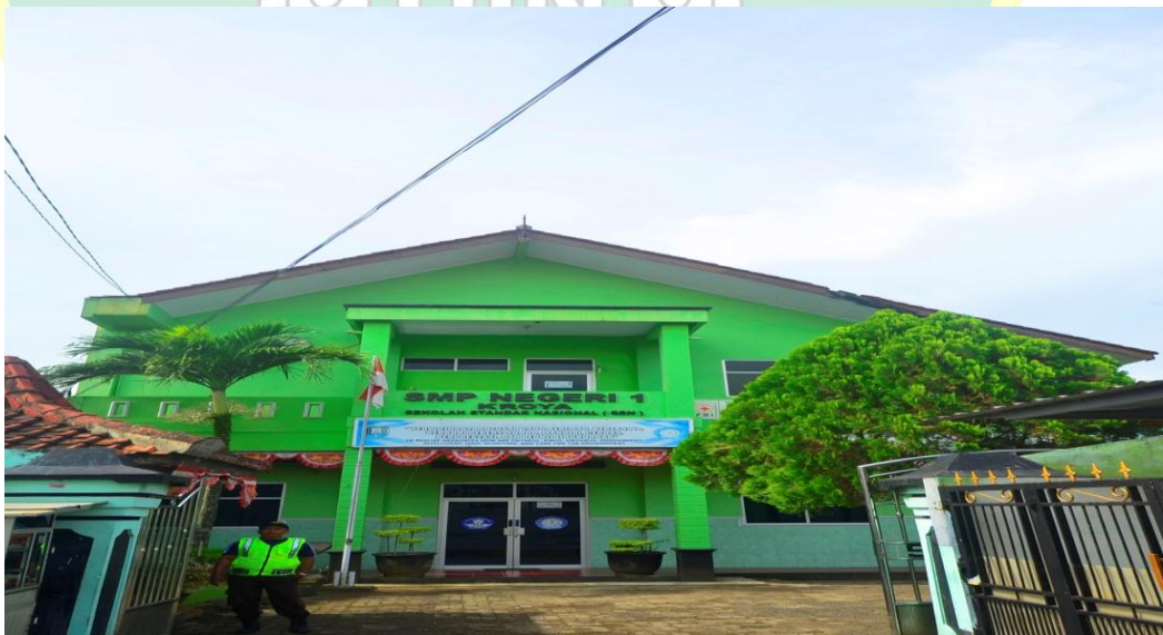
Gambar I Fisik Bangunan SMP Negeri 1 Kroya
