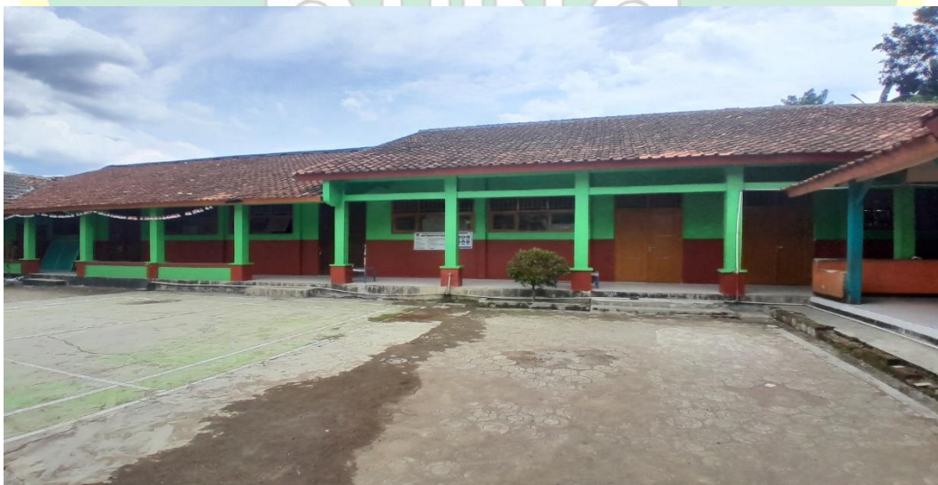
1.6 Keadaan bangunan gedung sekolah SD Negeri Surusunda 03
