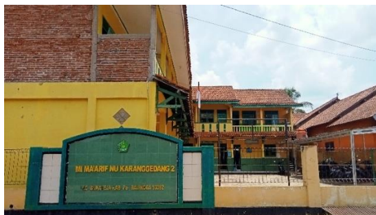
Gambar 3. Kondisi sekolah gedung 1
