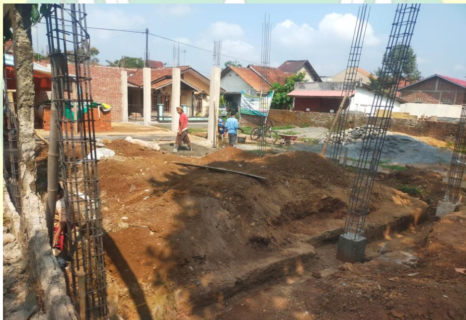
(Dokumentasi Lahan Perluasan Gedung Madrasah MI Ma'arif Al Falah Joyokusumo Banjarnegara)
