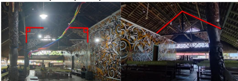
Gambar 3. Sudut 90^\circ dan 120^\circ Pada Rumah Lamin Adat Pemung Tawai
