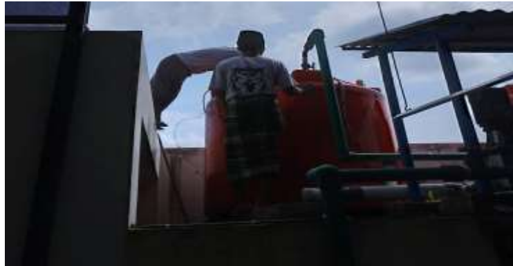
Pemantauan Pembetulan Pipa Gedung Putri
