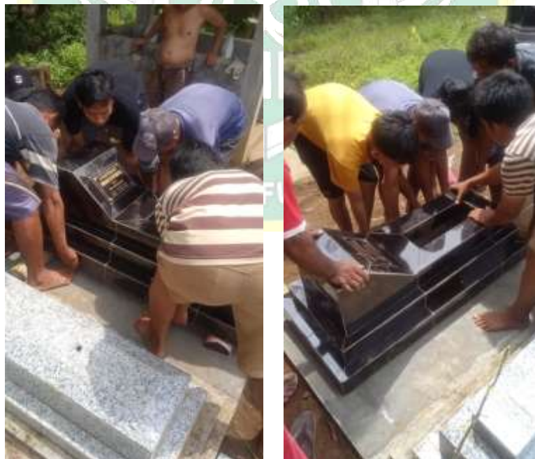
Foto Proses Pemasangan Kijing
