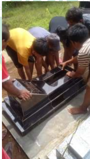
Gambar 2. Dokumentasi pemasangan kijing
