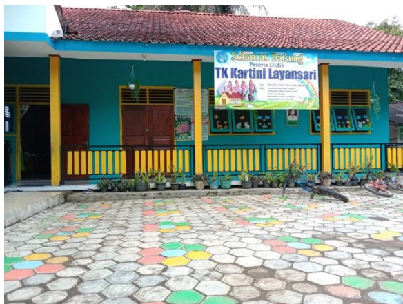
Gedung tampak depan TK Kartini Desa Layansari Kecamatan Gandrungmangu
