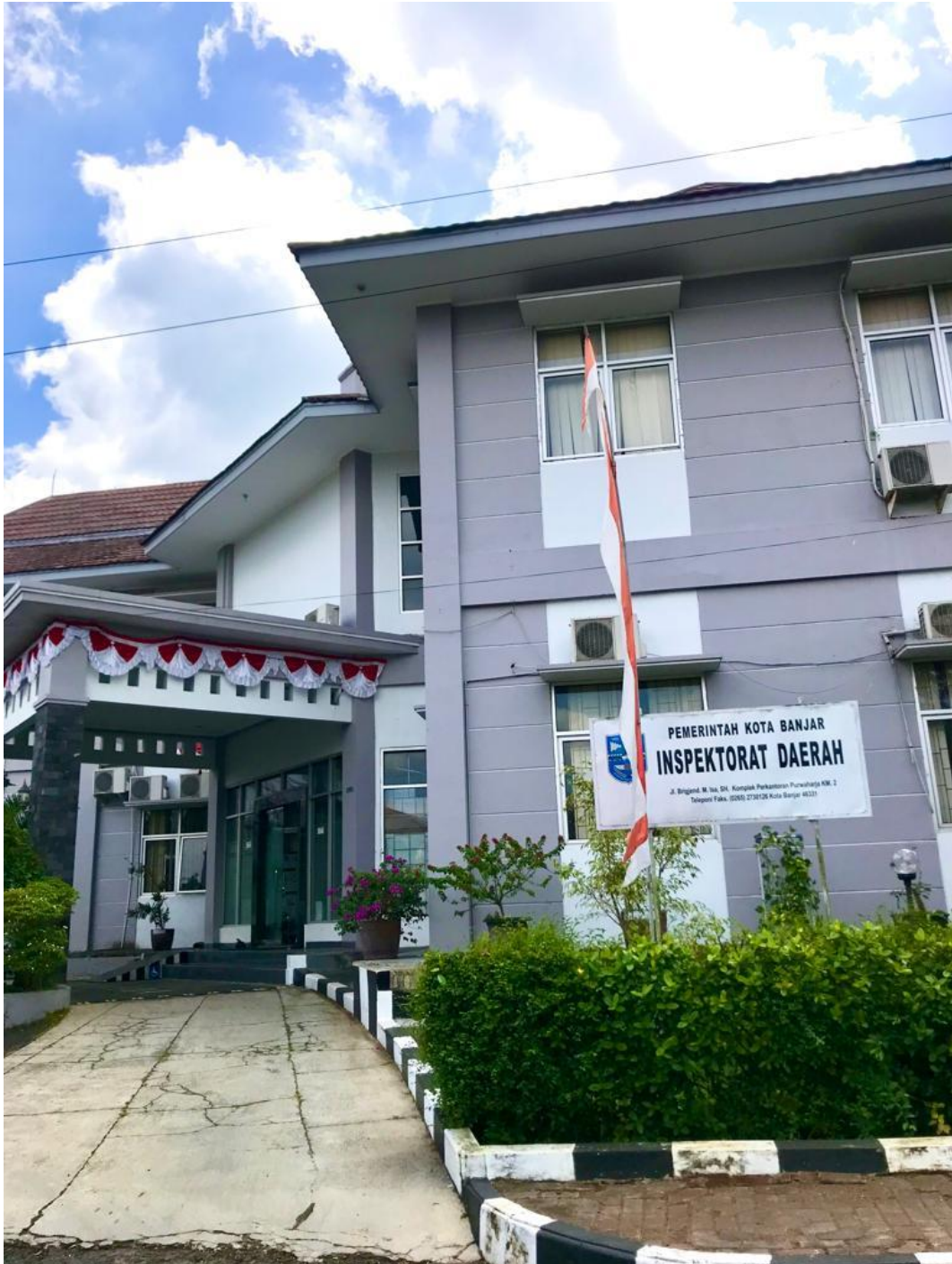
Gambar 1. Gedung Inspektorat Daerah Kota Banjar
