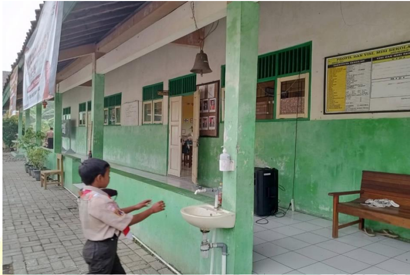
Gambar 4. 3 Keadaan Bangunan Gedung Sekolah SD N 2 Linggasari.
