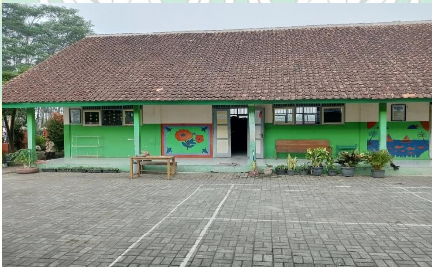
Gambar 4. 6 Keadaan Gedung dan Ruang Kelas SD N 2 Linggasari.
