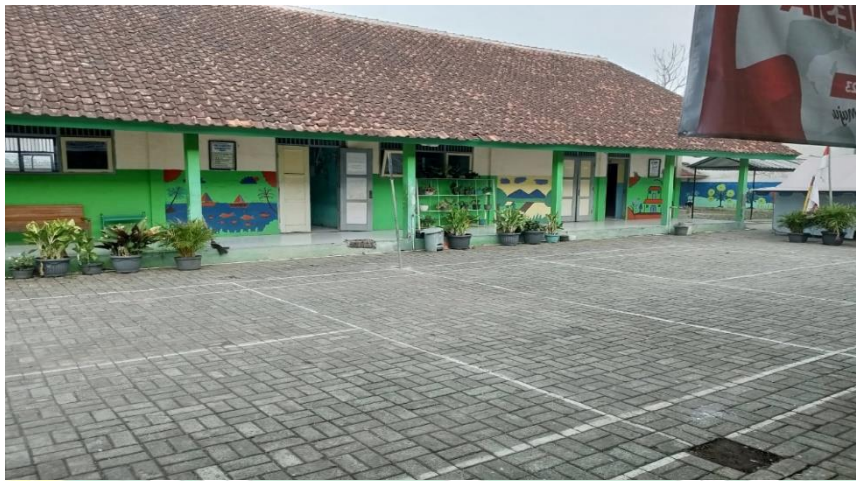
Gambar 4. 5 Keadaan Gedung dan Ruang Kelas SD N 2 Linggasari.
