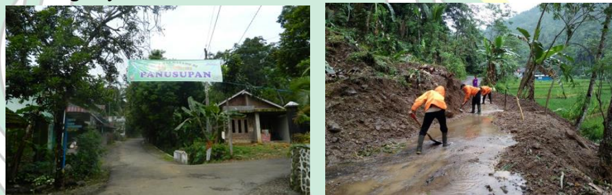
Gambar 9 : Akses jalan desa Panusupan menuju wisata
