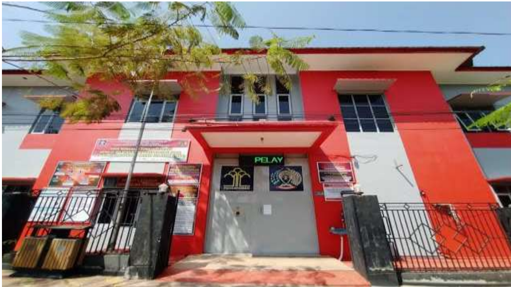
Gedung Rumah Tahanan Negara Kelas IIB Banjarnegara
