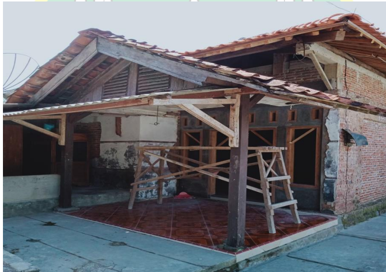
Gambar 4. 2 Rumah TKW Dalam Proses Renovasi
