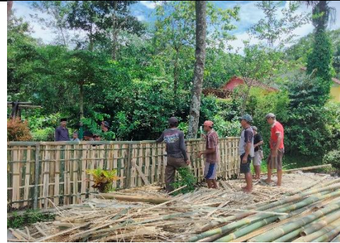
Pemasangan Jaro di Area Rumah Juru Kunci
