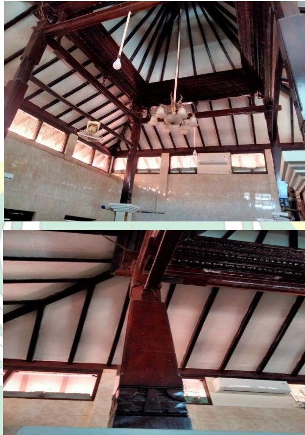
Gambar 10: Empat tiang utama (saka guru) Sumber: Dokumentasi penulis pada 16 Oktober 2022
