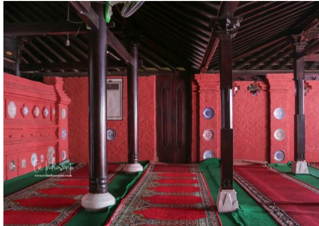
Gambar 2: Umpak batu pada Masjid Merah Panjunan sumber: https://www.eviindrawanto.com/2018/12/masjid-merah-panjunan-cirebon/ diakses pada 19 Maret 2023 pukul 18.39 WIB.
