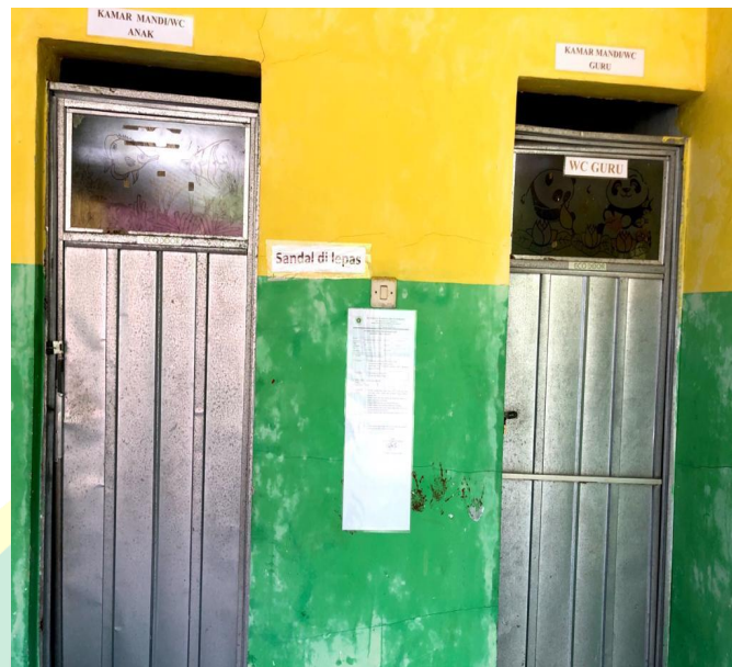
Gambar 4.2 Kondisi Kamar Mandi
