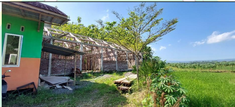
Proses Pembangunan Ruang Kelas Baru
