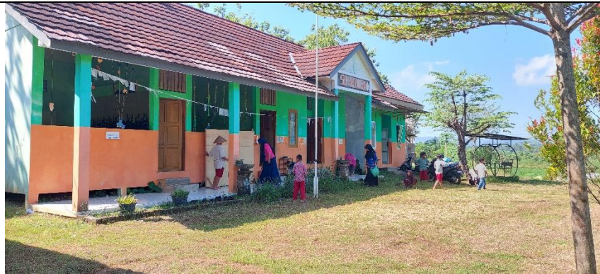
Bangunan dan Halaman SD Alam Hayuba
