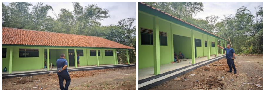
Gambar 4. Monitoring kepala sekolah pada pembangunan asrama
