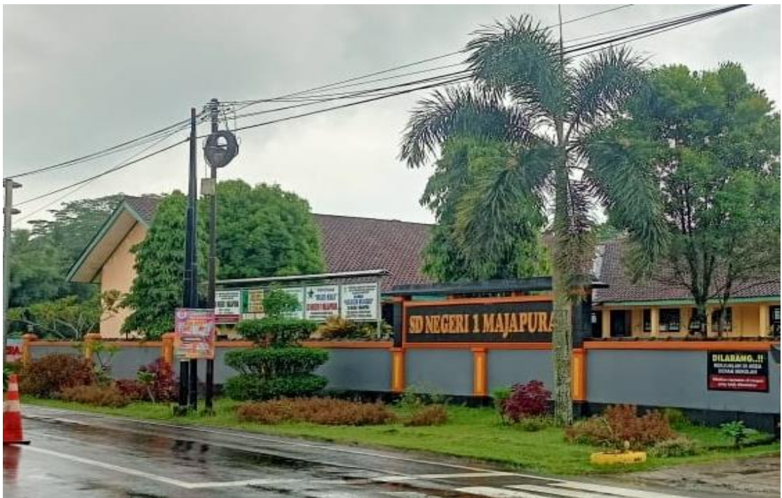
Gambar 1 Bangunan Gedung SD Negeri 1 Majapura Kecamatan Bobotsari – Kabupaten Purbalingga
