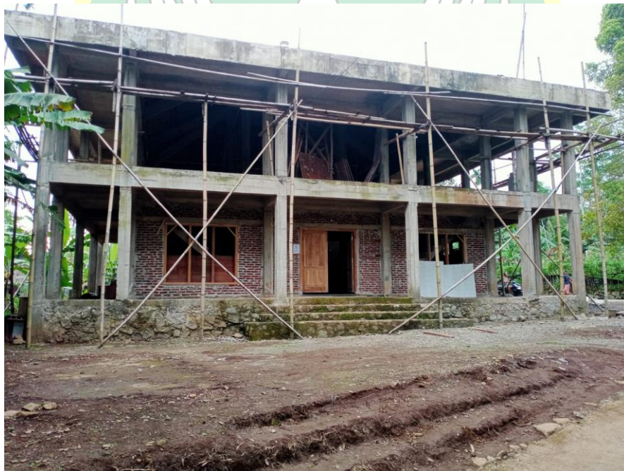
Bakal Bangunan Masjid Ponpes dan MTs Anwaarul Hidayah
