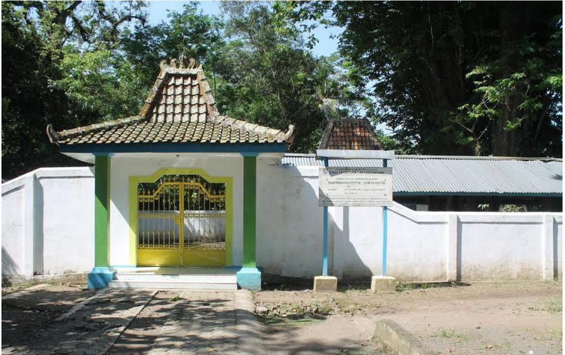
Foto : Tampak depan panembahan Depok
