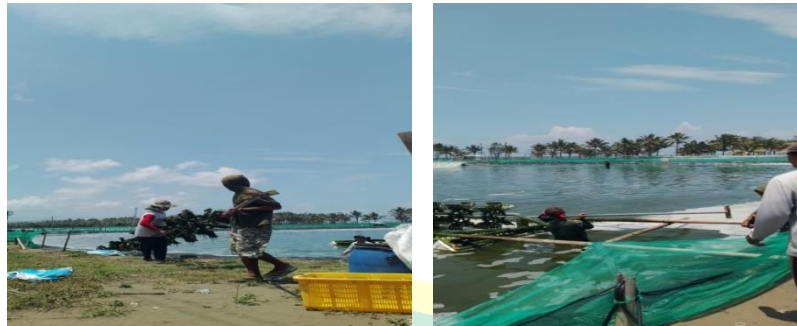
Gambar 4.2 Pemasangan Kincir Pada Tambak
