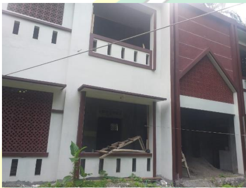
Kondisi Gedung TPQ
