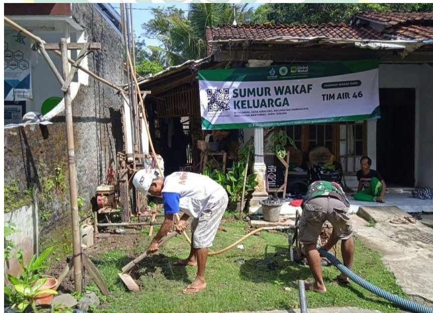
Proses Pembuatan Sumur Wakaf
